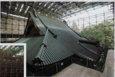
(上) 銅板瓦解体前 (左) 銅板瓦解体後
