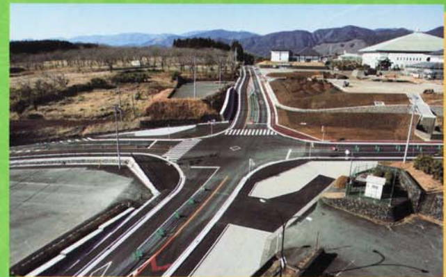
バスターミナル南側交差点改良工事
